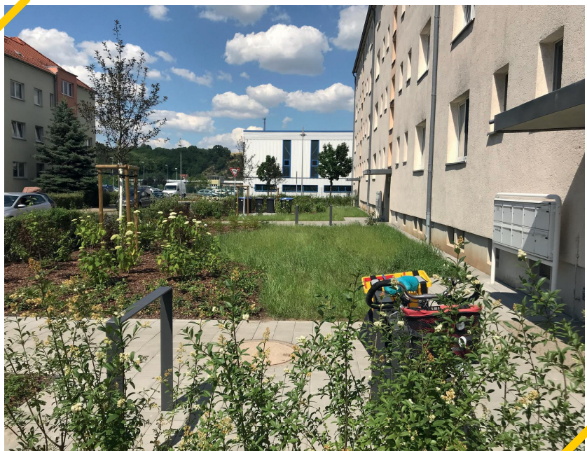
Neue Pflasterflächen und Pflanzen vor den Hauseingängen Wolyniezstraße 8-14
