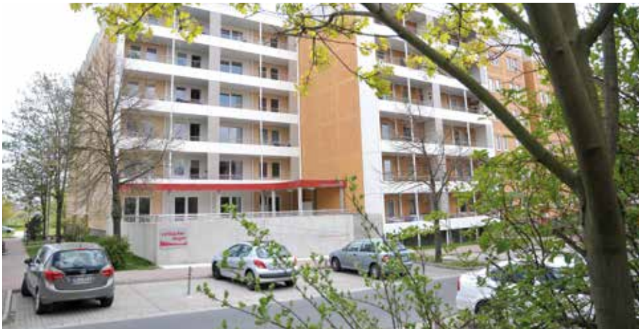
Fellbacher Bogen: Haupteingang mit großzügiger Terrasse
